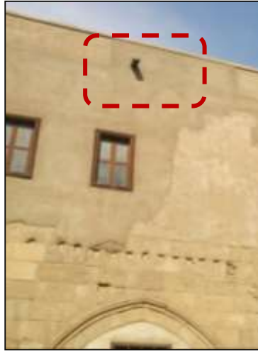
شكل (12) يوضح مصارف المياه بسطح البيت
